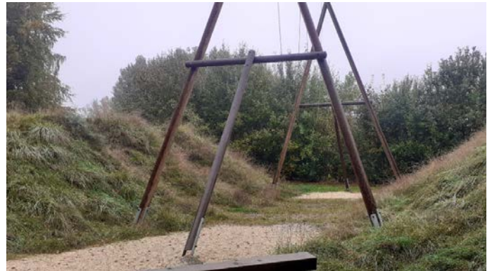
Der Fallschutz an der Riesenschaukel wurde mit einem soliden System aus Polyurethan und EPDM-Granulat erneuert.
