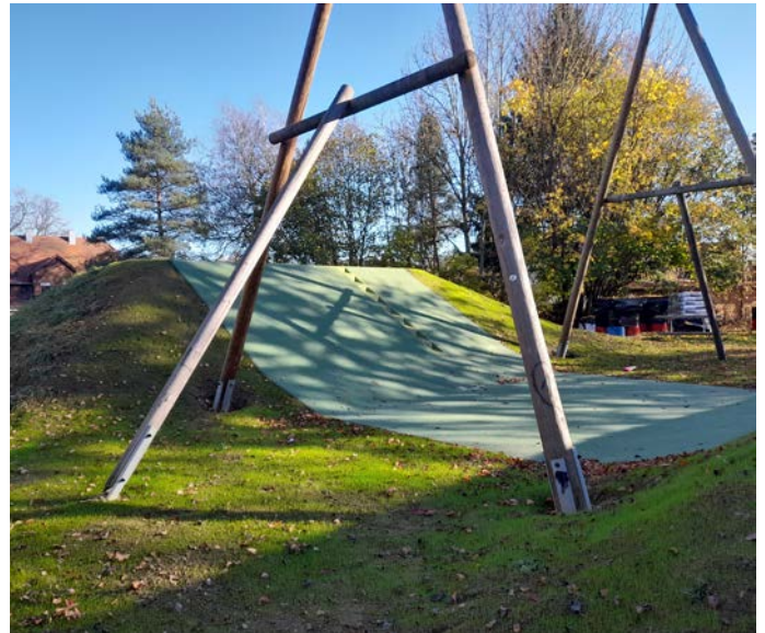
Der Fallschutz an der Riesenschaukel wurde mit einem soliden System aus Polyurethan und EPDM-Granulat erneuert.
