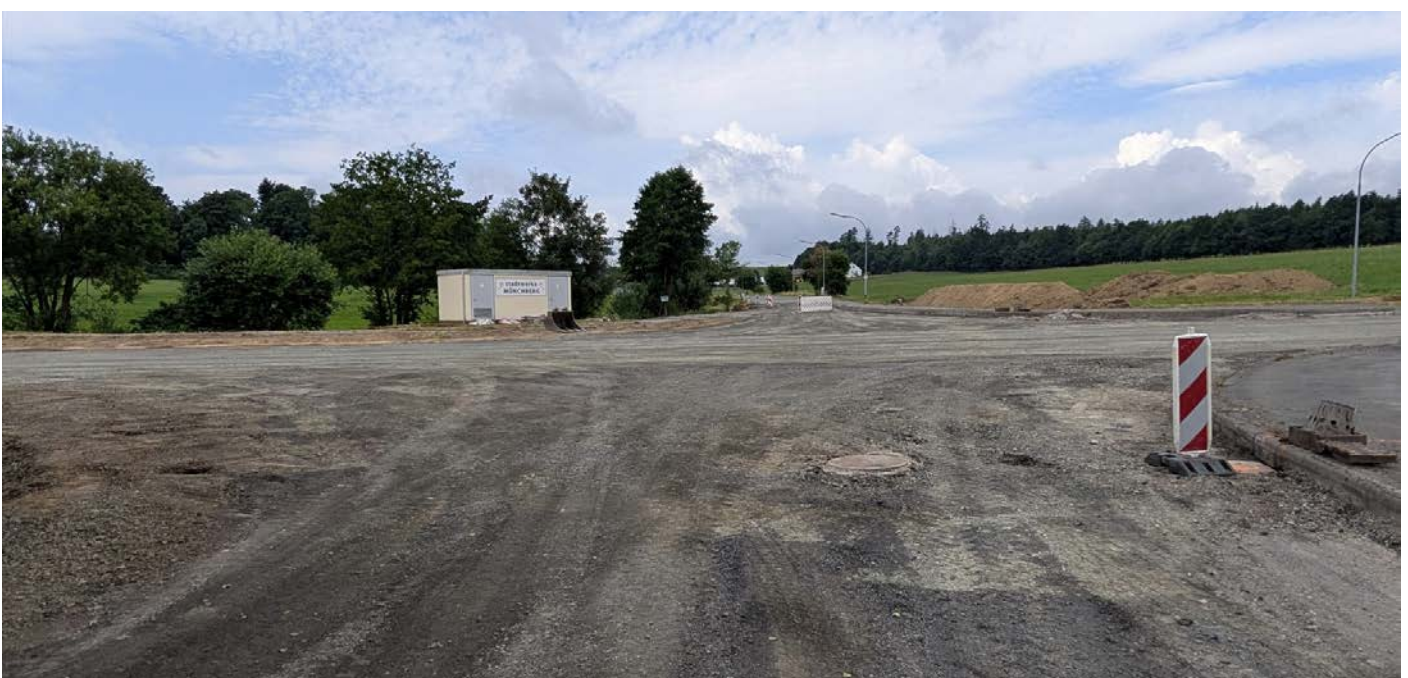
An der Kreuzung "Hintere Höhe" und B289 entsteht in der ersten Bauphase ein Kreisverkehr.
