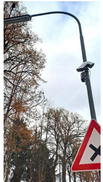
Auch in der Kreuzbergstraße sind die Sensoren am Laternenmast angebracht.
