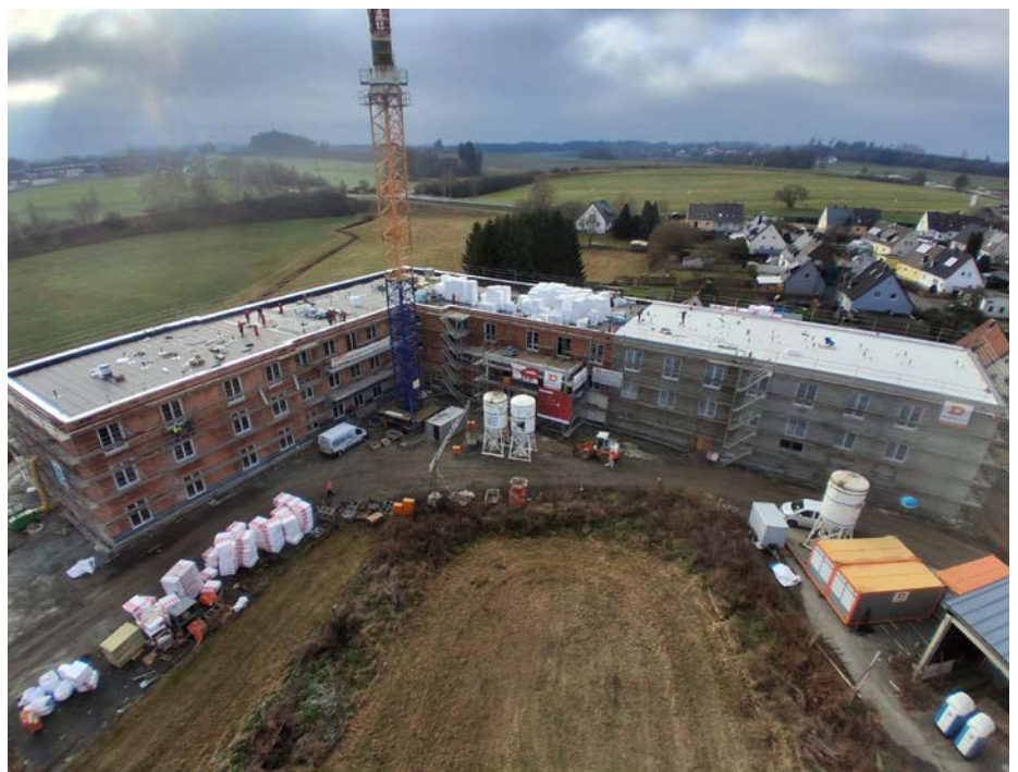
Im Sommer 2026 soll das neue Pflegeheim auf dem Gelände des ehemaligen Sägewerks Künzel an der Sparnecker Straße fertig sein. Danach geht's mit dem Bau des Dienstleistungsgebäudes weiter.
