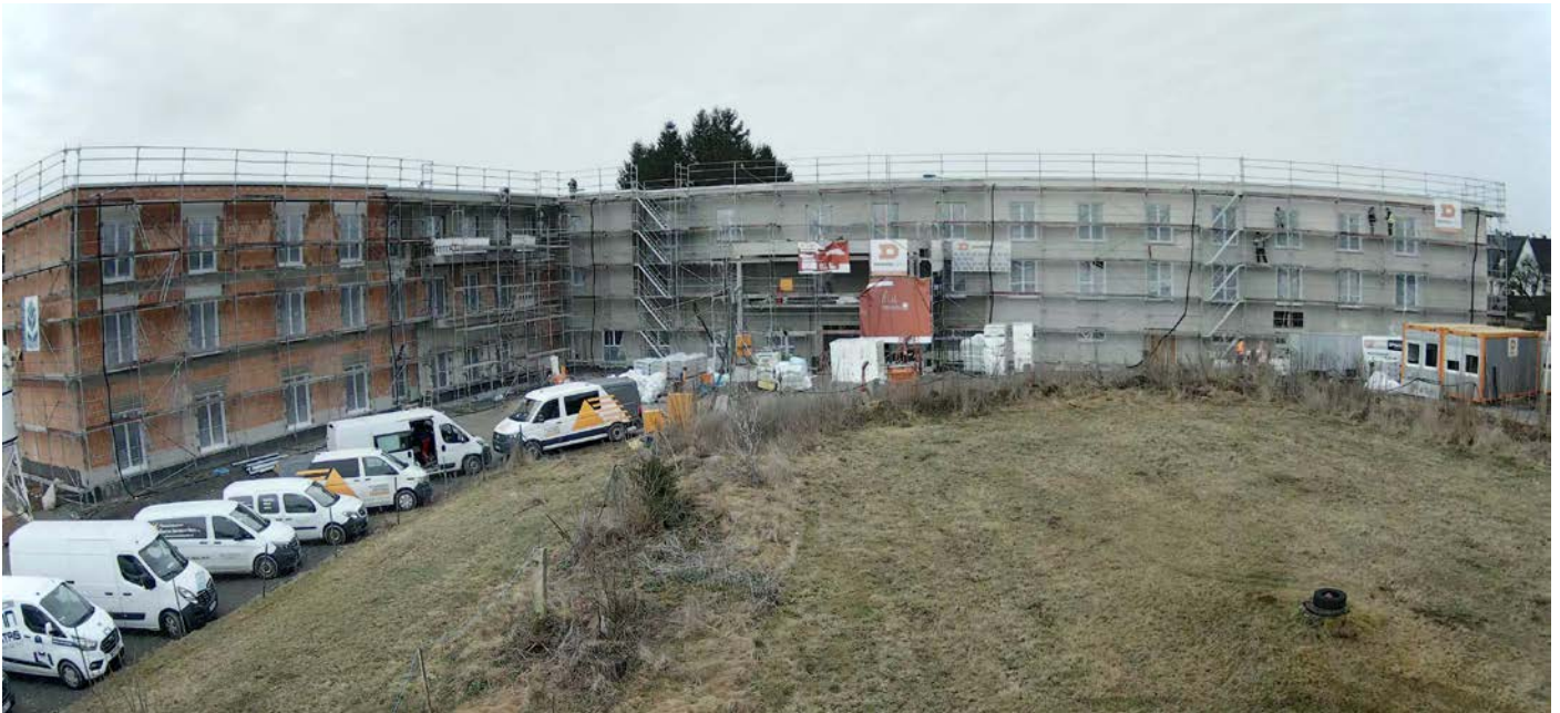
Es geht voran: Aktueller Blick auf die Baustelle des neuen Pflegeheims auf dem Gelände des ehemaligen Sägewerks Künzel.
