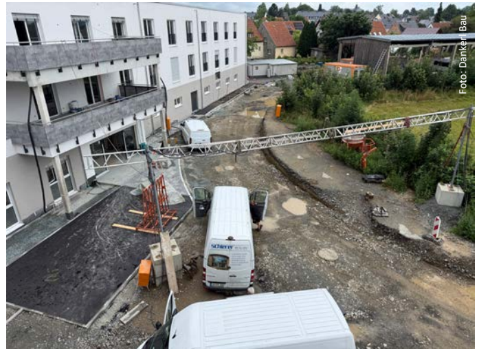
Auf der Baustelle des neuen Pflegeheims geht es zügig voran, sodass der Inbetriebnahme durch die Caritas im Herbst 2026 nichts im Wege steht. Im Moment laufen letzte Einrichtungsarbeiten.
